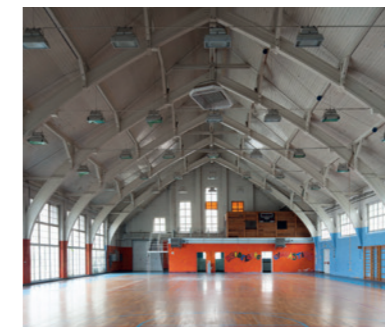
Innenansicht Halle; zuletzt genutzt als Turnhalle.
