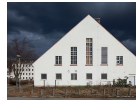
Denkmalgeschützte ehemalige Reithalle
